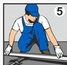
**5** Стяжку «Быстротвердеющая Основа БТ» разлейте на поверхности по маякам, установленным параллельно друг другу на расстоянии на 15-20% меньшем длины правила, и распределите широким правилом. Выравнивание поверхности производите за один прием, без перерывов.
