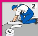
**2** Тщательно заделайте все отверстия и трещины в полу, чтобы предотвратить утечку выравнивающей смеси и усадку затвердевшего пола. По периметру помещения установите изоляционный шов с помощью кромоочной ленты.
