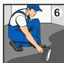
**6** Для получения гладкой поверхности стяжку после начала схватывания заглайте металлическим шпателем. При заливке помещений с площадью более 30 м<sup>2</sup> используйте деформационные швы на основе герметиков. Во время заливки и последующие 7 суток температура основания и помещения должна быть не ниже +5°C. Избегайте сквозняков на поверхности пола и в помещении, в ходе работы и последующие 24 часа. В течение 3 первых суток не допускайте попадания солнечных лучей в помещение.
